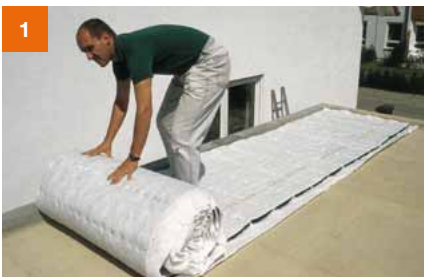
SDF-Matte auf der wurzelfesten Abdichtung ausrollen ...
