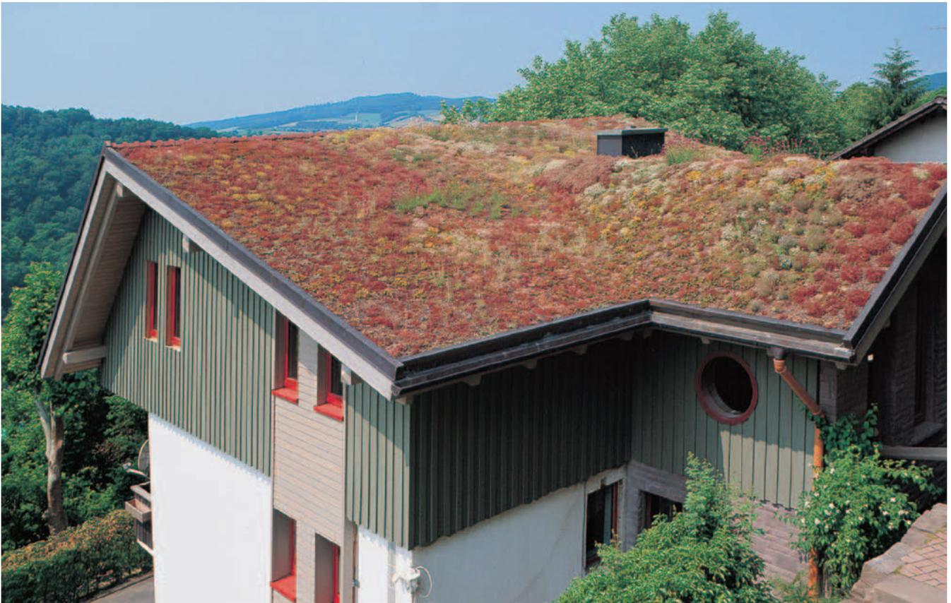
**Schrägdachbegrünungen erfordern spezielle Begrünungssysteme. Die Lagestabilität muss sichergestellt werden und als Ausgleich für den Oberflächenabflusses, bzw. die im Vergleich zum Flachdach stärkere Austrocknung sollte die Wasserrückhaltung erhöht werden.**
