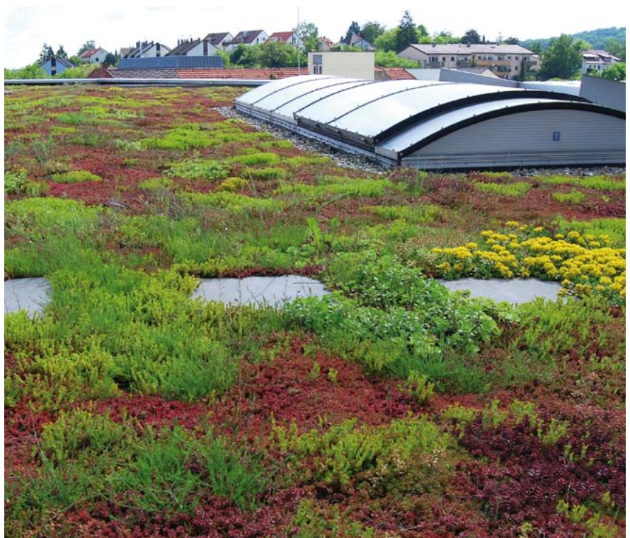
Beispiel Sedum: Sedumbegrünungen bilden einen dichten, weitgehend homogenen bodendeckenden Bestand. Die Artenvielfalt ist vergleichsweise gering. Auch während der Sedumblüte im Juni und Juli bleibt der Charakter einer homogenen bodendeckenden Begrünung erhalten.
